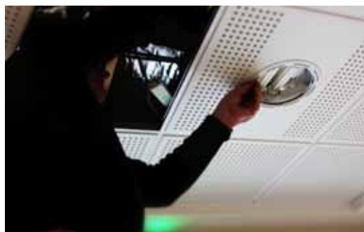
Changement des éclairages en LED
