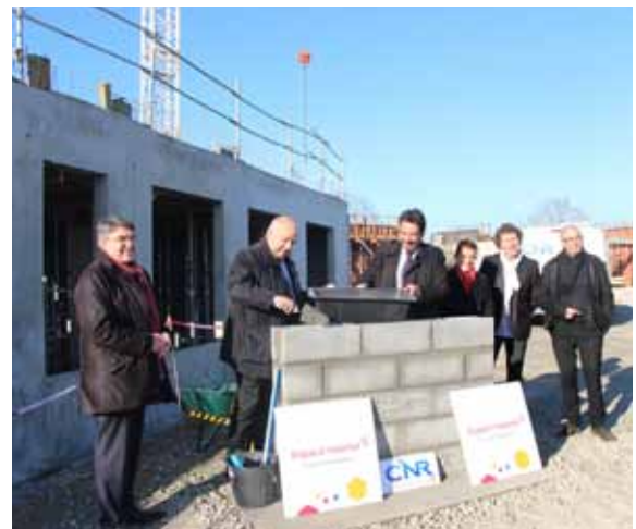
Urbanisme Pose symbolique de la première pierre de la Maison Helena
