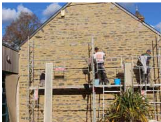
Travaux d'isolation des bâtiments
